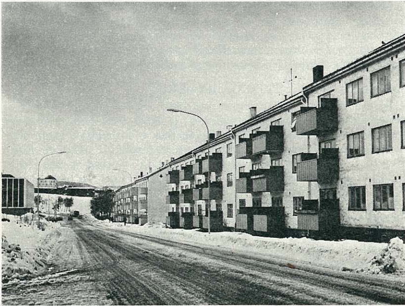
Rosenborg Borettslag — Stadsingenior Dahls gate.
